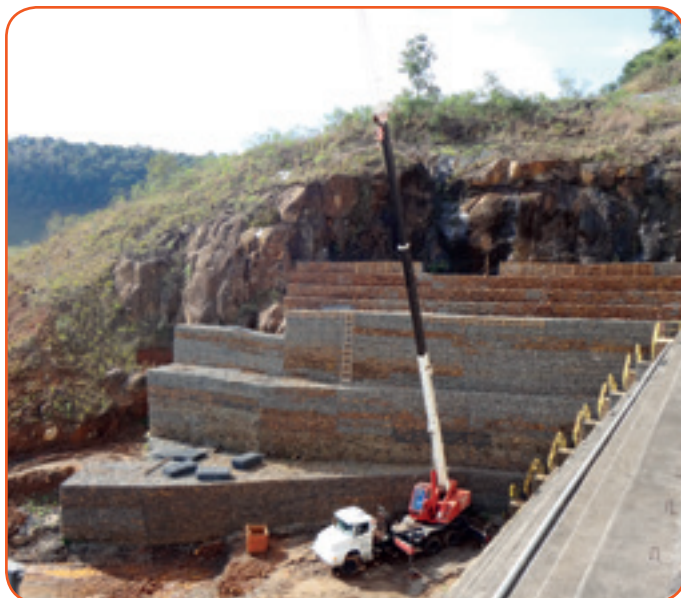
Contenção de maciços rochosos
