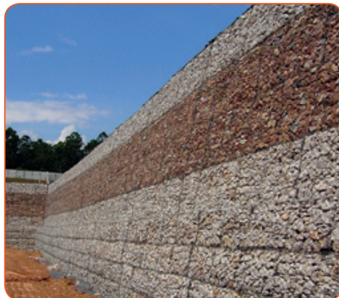
Contenção em platô de obra industrial
