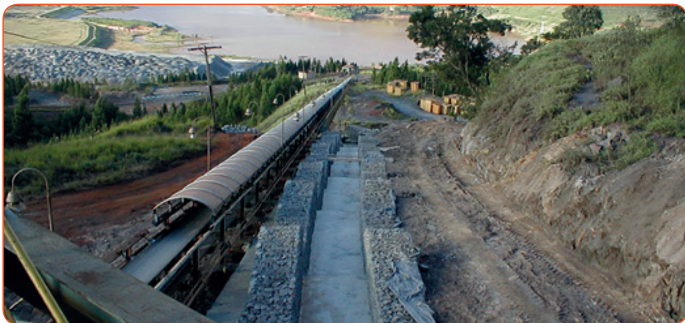
Obras de drenagem e controle de erosão em mineração
