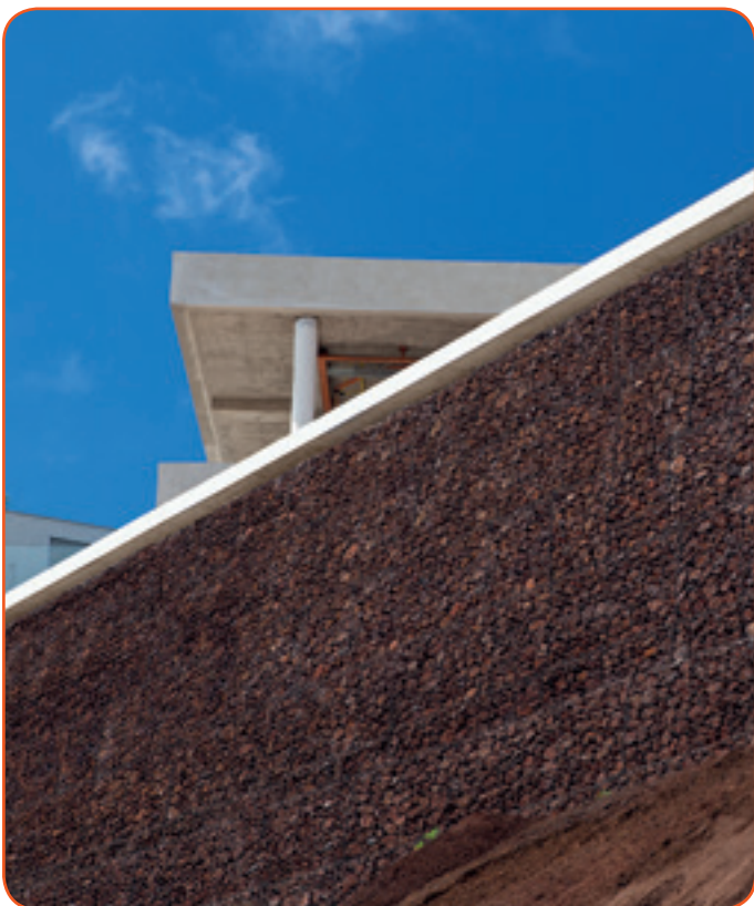
Muros de gravidade em obras prediais
